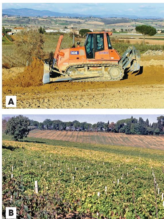
Figura 9.6 - Accantonamento dello strato di terreno superficiale prima dell'eliminazione di un dosso (A) e area clorotica con sviluppo stentato delle piante in un vigneto nel quale questa operazione non è stata eseguita (B).
